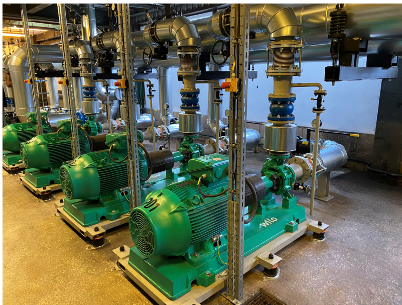
Fotografia 3. Pompy obiegowe P01 – P04 WILO-Atmos GIGA-N 80/200-55/2
