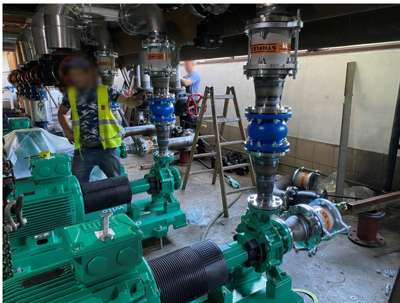
Fotografia 1. Prace montażowe pomp sieciowych Wilo Atmos GIGA-N
