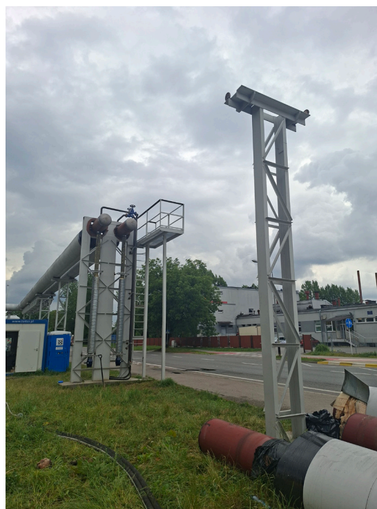
Rysunek 3. Sieć ciepłownicza tymczasowa w trakcie remontu sieci ciepłowniczej przy ul. Trembeckiego w Rzeszowie (MPEC, 2026)
