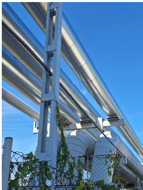
Rysunek 2. Wymiana izolacji na rurociągu zasilającym - stan po wymianie (MPEC, 2026)
