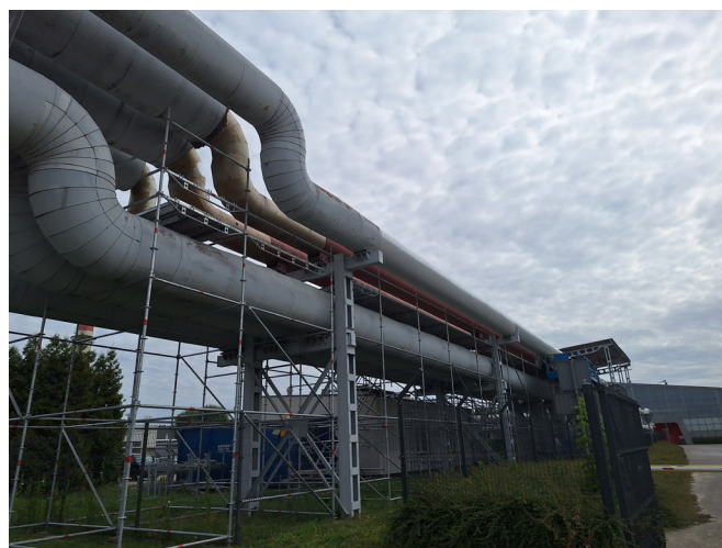
Rysunek 1. Wymiana izolacji na rurociągu zasilającym - stan przed wymianą (MPEC, 2026)
