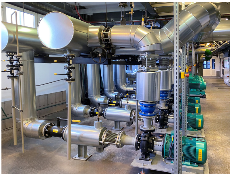
Fotografia 2. Pompy kotłowe K1- K4 WILO-Atmos GIGA-B 80/140-18,5/2
