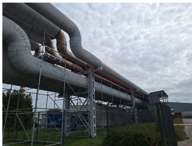
Rysunek 1. Wymiana izolacji na rurociągu zasilającym - stan przed wymianą (MPEC, 2026)
