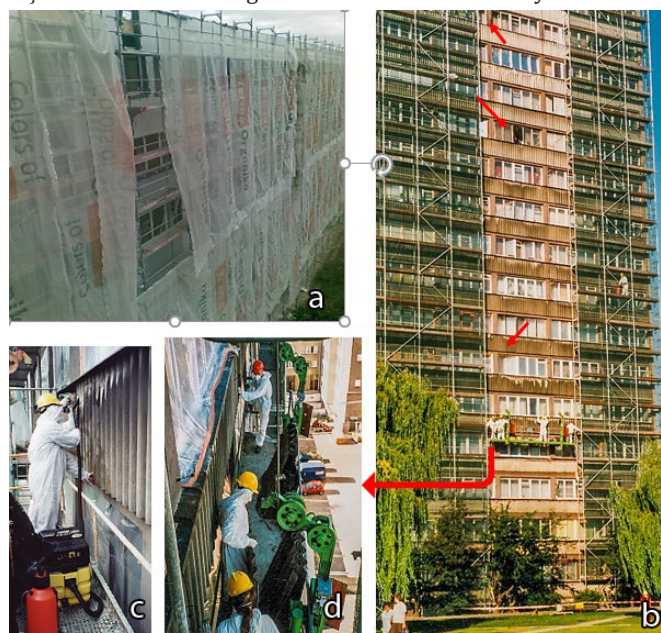
Rysunek 2. Etapy zabezpieczenia i demontażu elewacji. Brak izolacji strefy pracy od zewnątrz przedstawia (a, b). Wnętrze strefy pracy przedstawia (c, d). Brak hermetycznej strefy pracy skompensowano miejscowym odsysaniem powstających pyłów widocznym na (c). Źródło: opracowanie własne
