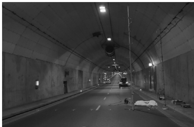
Rysunek 2. Statywy pomiarowe umieszczone w tunelu. Źródło: opracowanie własne Figure 2. Stand poles positioned within the tunnel's measurement section. Source: authors' own study
