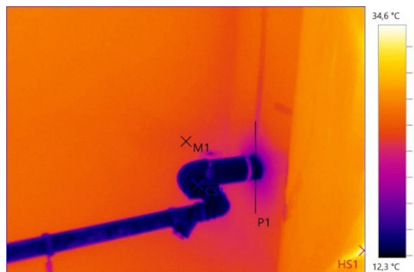
Rysunek 2. Przewód wody zimnej – wejście sieci wodociągowej do budynku DN100. Źródło: opracowanie własne
