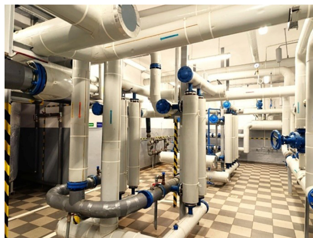
Rysunek 1. Analizowany węzeł ciepłowniczego. Źródło: opracowanie własne
