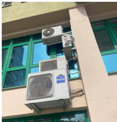
Rys. 15. Sposób montażu obniżający efektywność, zdjęcie własne autorów Fig. 15. Mounting method reducing energy efficiency, photo taken by the authors
