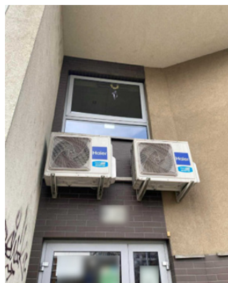
Rys. 16. Sposób montażu we wnęce ograniczający ruch powietrza, zdjęcie własne autorów Fig. 16. Mounting method in a recess limiting air circulation photo taken by the authors
